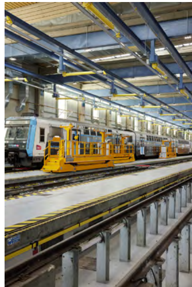
Technicentre de Joncherolles : la fosse technique et les rails sur potelets, photo : Maxime Huriez
