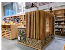
Prototype de mise en œuvre de matériaux de réemploi : bois et pierres meulières en gabion
