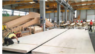
Fabrication de l'abri solaire en usine, janvier 2024, photo : Gabriel Robinne
