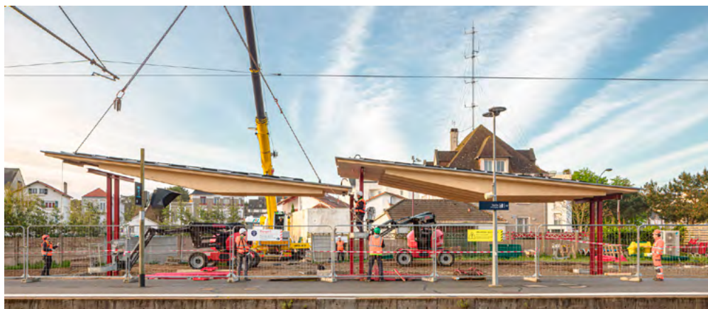
Installation du prototype à La Baule, 2024.
