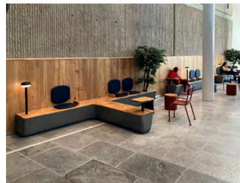
Mise en œuvre de lambris en rebut de traverses bois, Paris, gare de Lyon, juillet 2024, photo : Vincent Jurine
